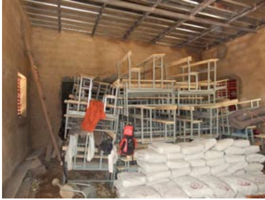
salle de classe + tables - bancs & ciment entreposés le temps de la finition des autres salles
